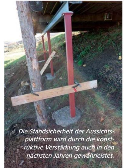
Die Standsicherheit der Aussichtsplattform wird durch die konstruktive Verstärkung auch in den nächsten Jahren gewährleistet.
